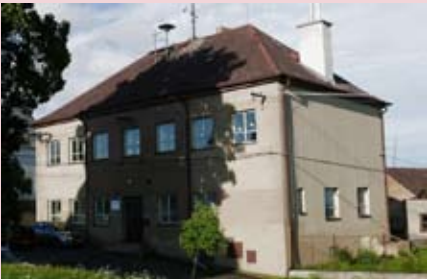
Základní škola v Lístanech před a po opravě střechy a výměně oken.
